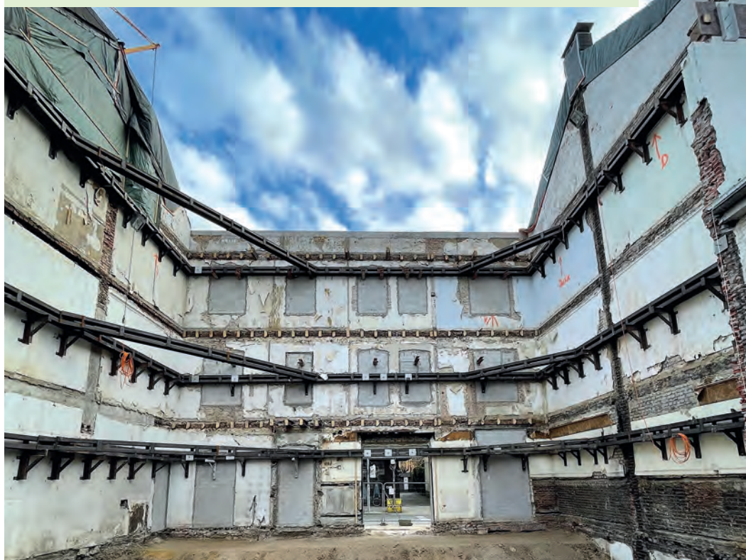
Der Neubau des FORUM.Lotsenpunktes erfolgte hinter der historischen Fassade.
