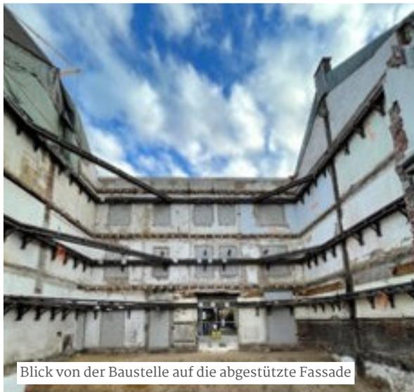
Blick von der Baustelle auf die abgestützte Fassade
