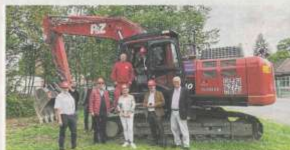
Die Bauarbeiten haben begonnen. Das Don-Bosco-Haus war zuvor zu eng für alle Angebote geworden.
