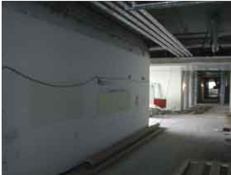
Kernsanierung St. Heribert, Baustelle im Erdge- schoss, Foyer
